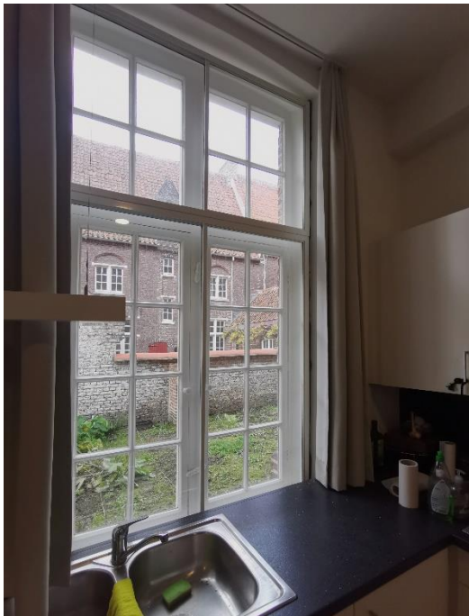
Figuur 11. Slanke aluminium schuiframen als nieuwe achterzetramen in convent 22.
