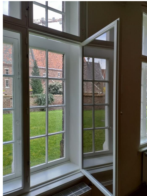
Figuur 12. Houten achterzetramen met enkel glas in de feestzaal in convent 62.
